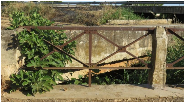
Figura 6 - Particolare ponte della Bonifica
