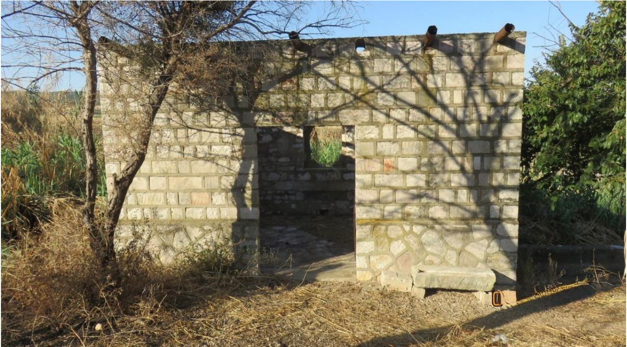
Figura 5 - Casetta della Bonifica integrale sul pilone
