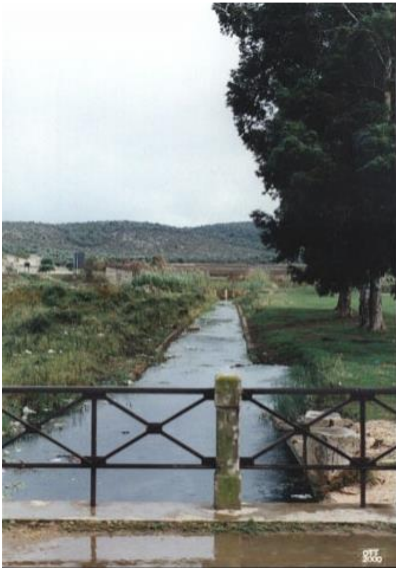
Figura 7 - Ponte e canale della Bonifica integrale
